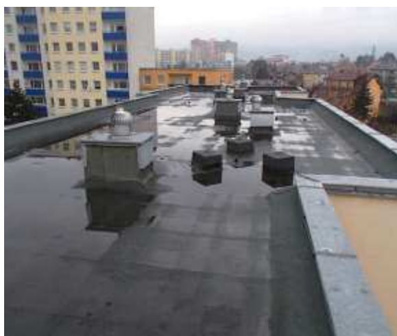
Původní vzhled střechy
