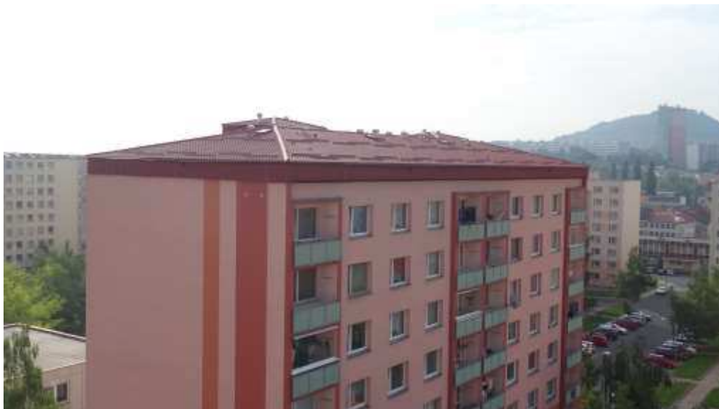
Konečný vzhled střechy
