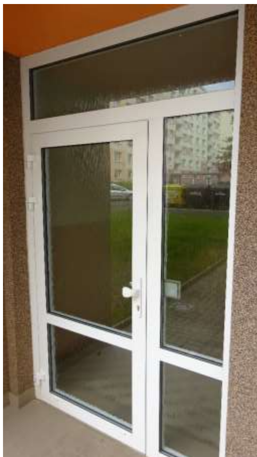
Ukázka výměny vstupních sestav do objektů
