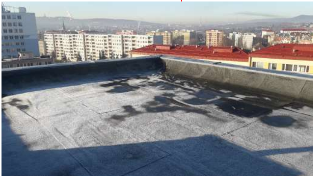
Průběžné stavební práce
