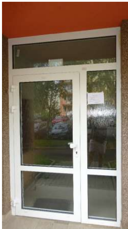
Ukázka výměny vstupních sestav do objektů
