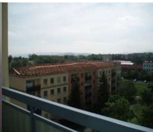
Pohled na vazníky zvenku
