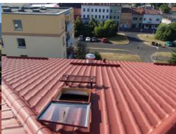
Výlez na střechu
