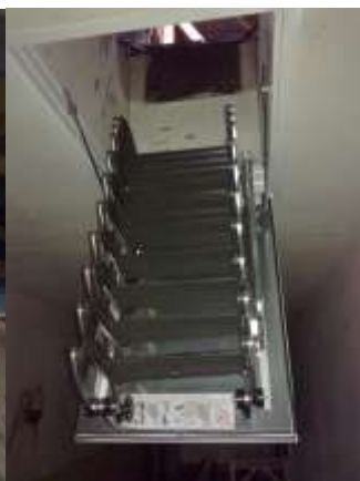
Výlez na střechu z chodby
