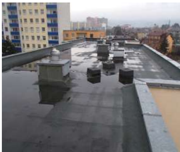
Původní vzhled střechy
