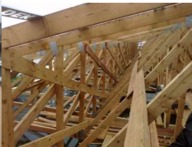
Pohled na vazníky zevnitř
